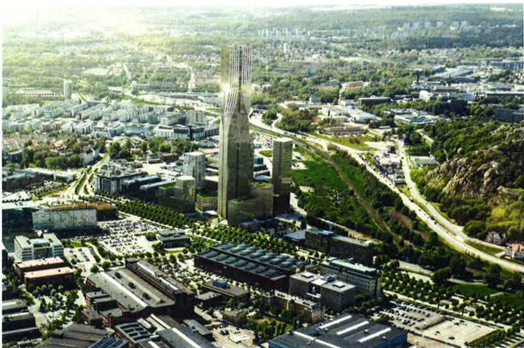
Planområdet med sina byggnadsvolymer i varierande höjder.
